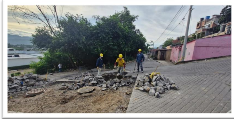
Demolición de pavimento rígido
