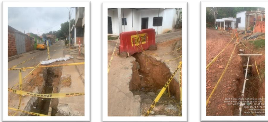
Fotografía No. 14,15 y 16. Instalación de línea de impulsión tanque morichal
