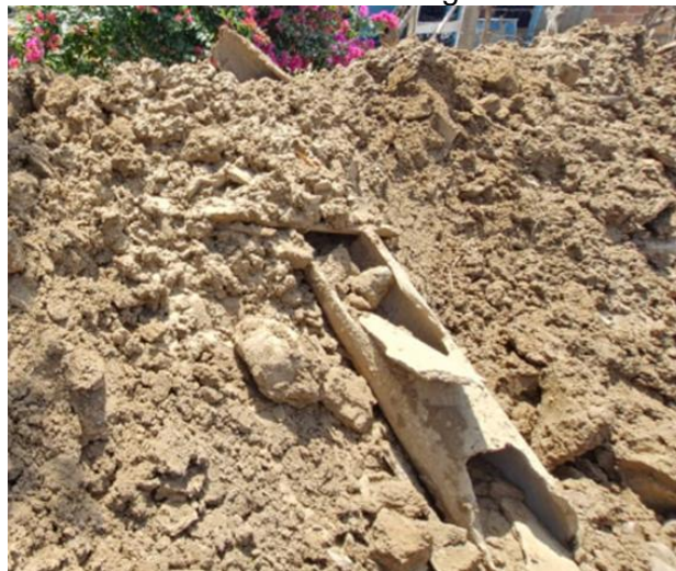
Retiro tubería de gres
