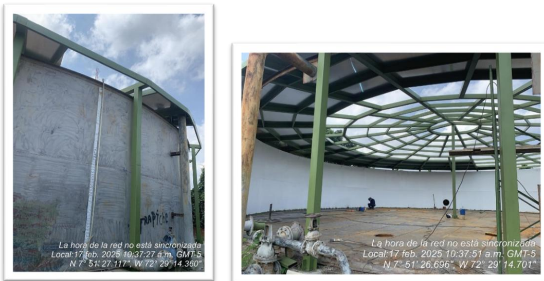
Fotografías No. 17 y 18. Avance cubierta tanque Navarro Wolf
