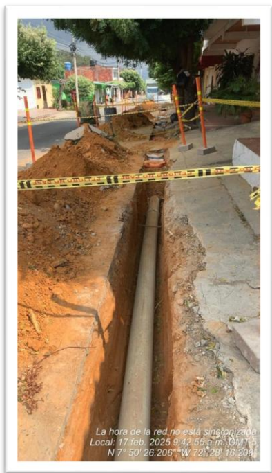
Fotografía No. 12 y 13. Reposición de tubería PVC Ø 8" Acueducto carrera 8 calles 1N hasta la 3
