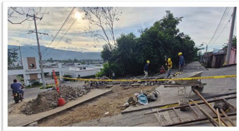
Demolición de pavimento rígido
