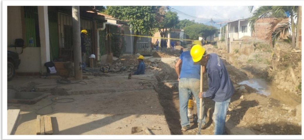
Retiro tubería de gres
